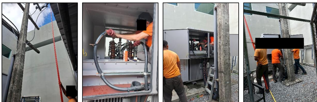
รูปที่ 3-30 เจ้าหน้าที่ดูแลซ่อมแซมและบำรุงรักษาหม้อแปลงไฟฟ้า
