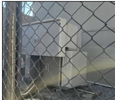
รูปที่ 3-29 จัดให้มีหม้อแปลงไฟฟ้าแยกเฉพาะ ติดตั้งห่างจากอาคาร และอยู่ในตำแหน่งที่เจ้าหน้าที่เข้าได้สะดวก และจัดให้มีแผงกั้นล้อมรอบหม้อแปลงไฟฟ้า และป้ายเตือนระวางไฟฟ้าแรงสูง
