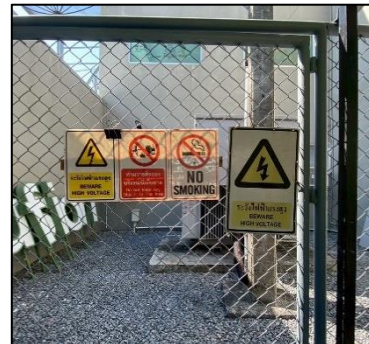
รูปที่ 3-29 จัดให้มีหม้อแปลงไฟฟ้าแยกเฉพาะ ติดตั้งห่างจากอาคาร และอยู่ในตำแหน่งที่เจ้าหน้าที่เข้าได้สะดวก และจัดให้มีแผงกั้นล้อมรอบหม้อแปลงไฟฟ้า และป้ายเตือนระวางไฟฟ้าแรงสูง
