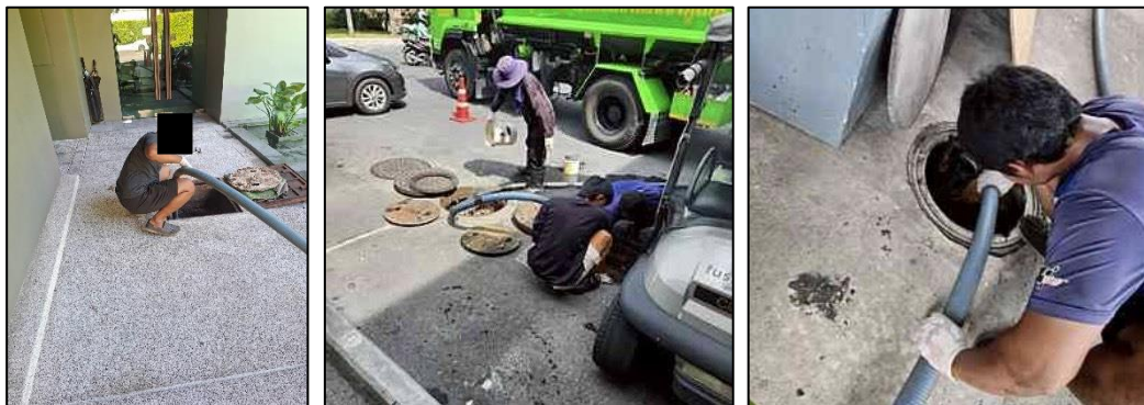
รูปที่ 3-12 เจ้าหน้าที่สูบน้ำตะกอนส่วนเกินจากระบบบำบัดน้ำเสีย
